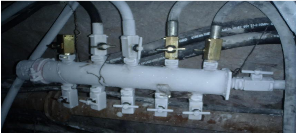
图 3 气（液）路分流控制器
