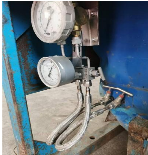
图 6 更换高压低温不锈钢金属软管
