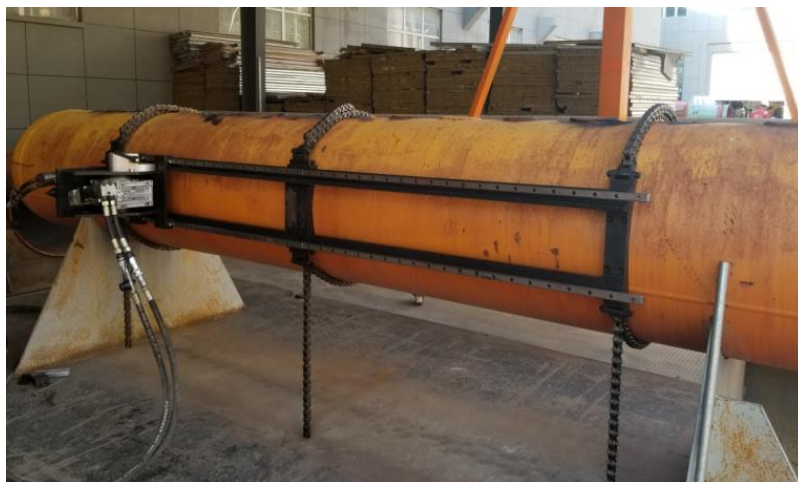
水平管道切割
