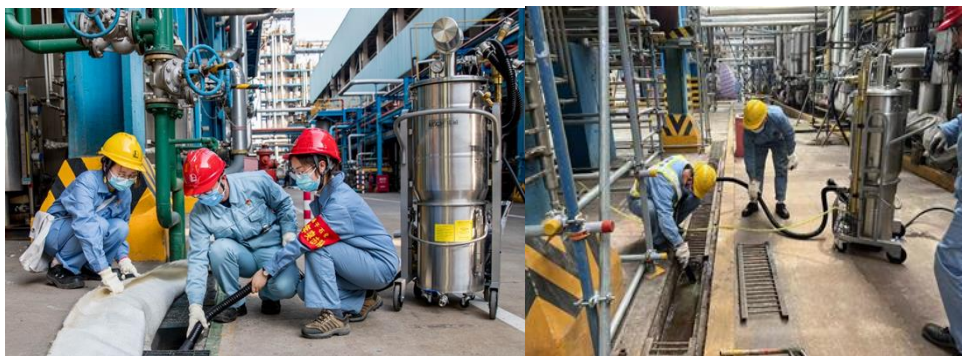
扬子石化检修现场应用
