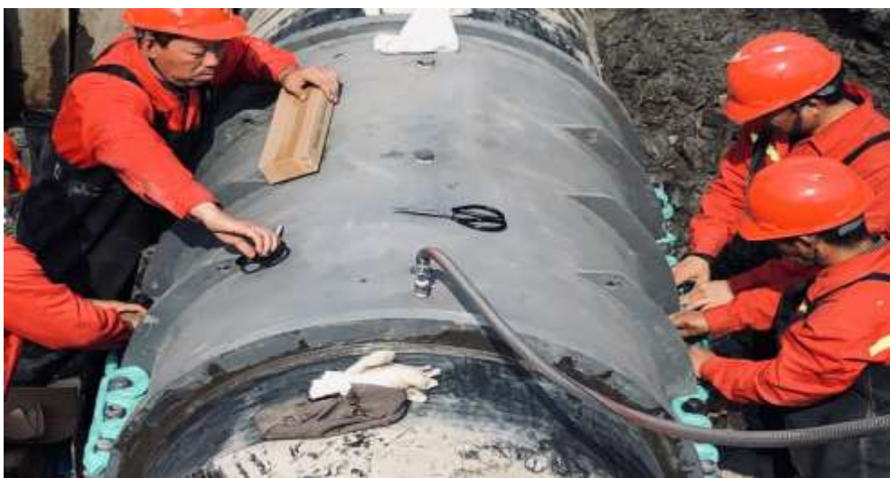
图 2 现场安装新型非焊接修复套筒
