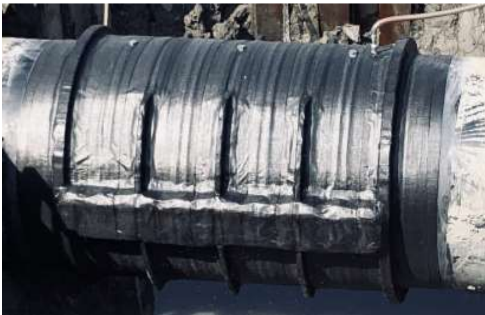
图 3 新型非焊接修复套筒安装防腐后的现场状态
