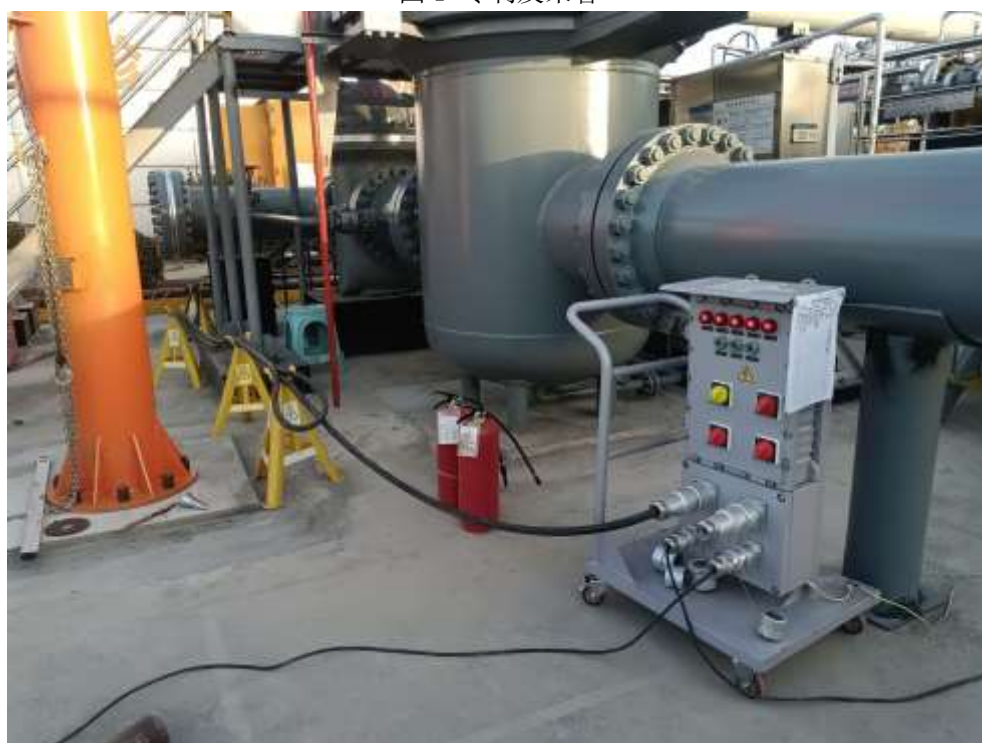
图 2 实物及使用照片- 湖州作业区长兴输油站工艺管网改造使用现场
