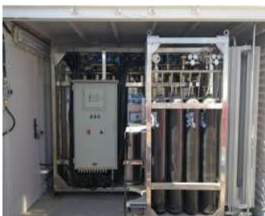
图 3 液氮冷却与控制系统主视图
