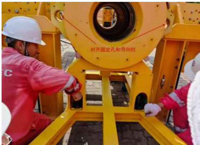
图 2 海管机械连接器载入安装设备中
